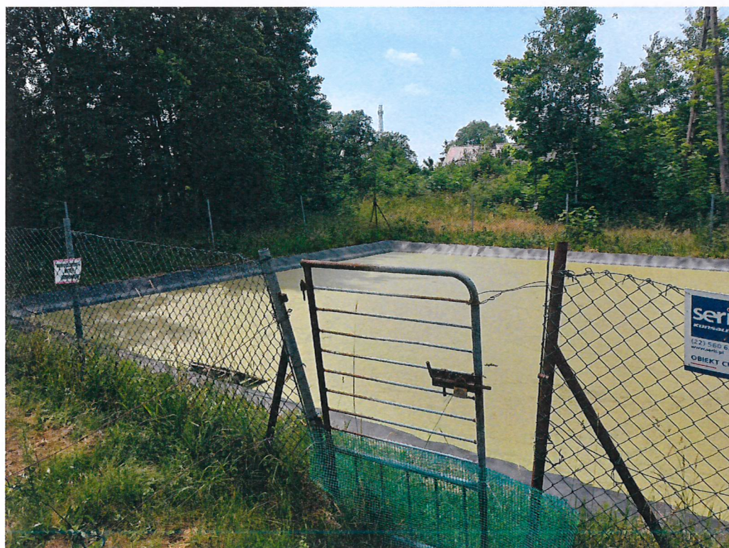
Fot. 15 Działka nr 71/7 obręb Czechy – południowo - zachodnia część zakładu – zbiornik przeciwpożarowy
