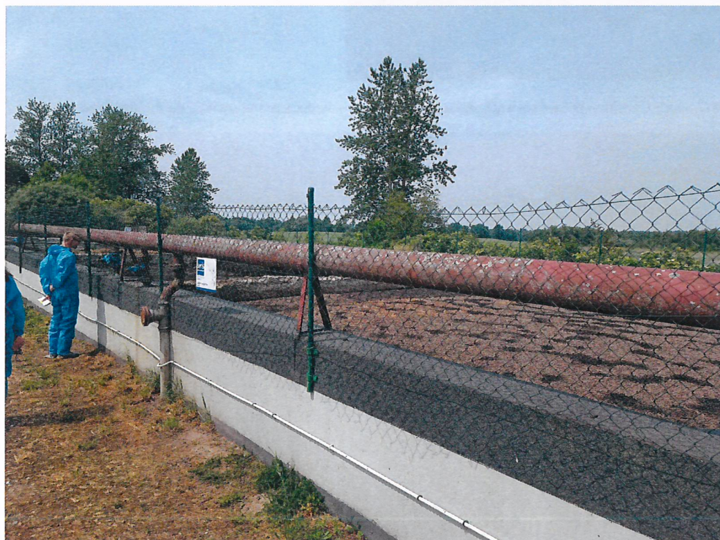
Fot. 11 Działka nr 71/7 obręb Czechy – północna część zakładu – widoczne zbiorniki na gnojowicę
