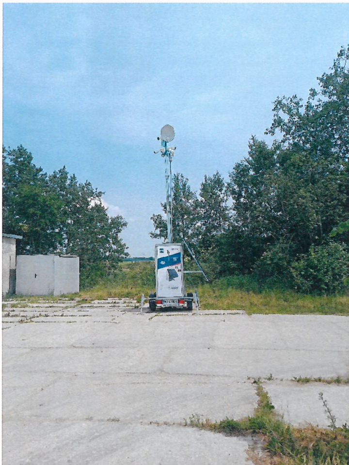
Fot. 8 Działka nr 71/7 obręb Czechy – północno-wschodnia część zakładu – widoczne stanowisko do monitoringu wizyjnego
