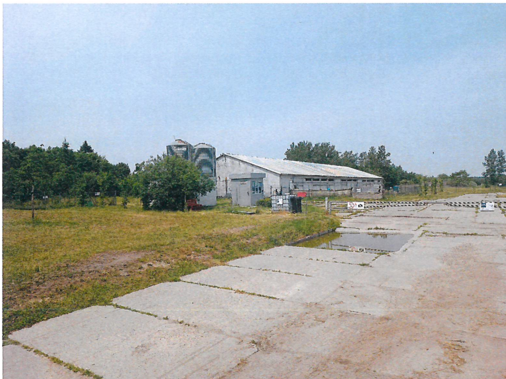
Fot. 1 Działka nr 71/7 obręb Czechy - wjazd na teren zakładu – widoczna brama oraz stanowisko do dezynfekcji.
