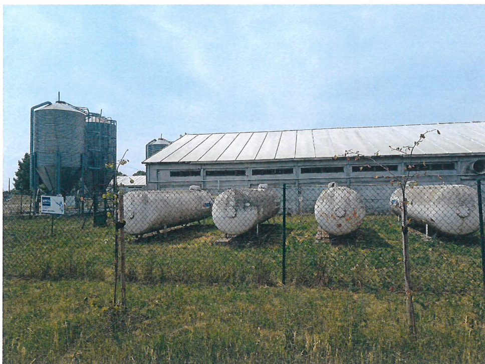
Fot. 4 Działka nr 71/7 obręb Czechy – wschodnia część zakładu
