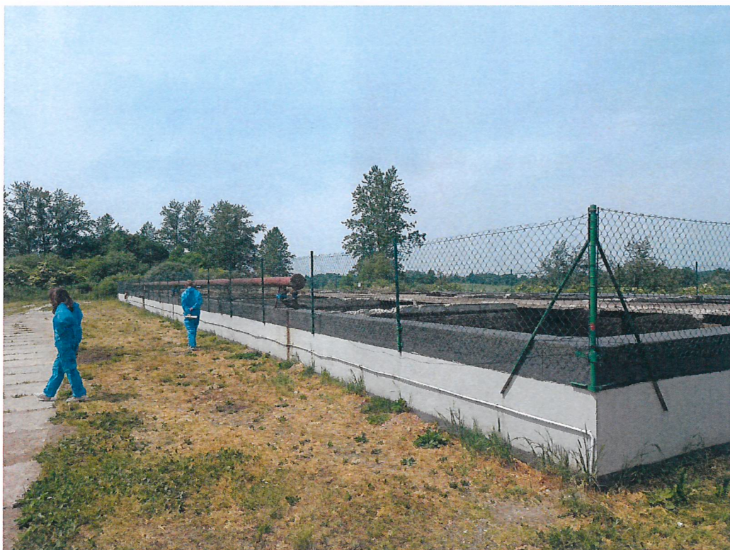
Fot. 10 Działka nr 71/7 obręb Czechy – północna część zakładu – widoczne zbiorniki na gnojowicę
