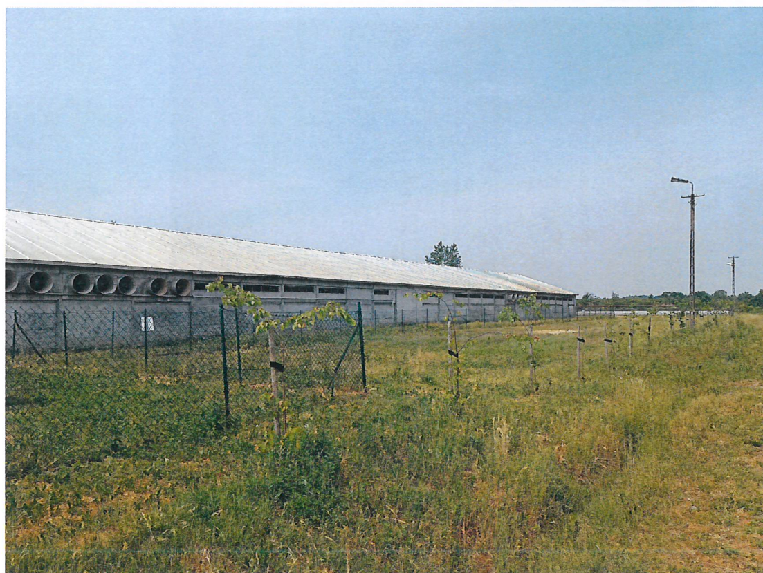
Fot. 5 Działka nr 71/7 obręb Czechy – wschodnia część zakładu
