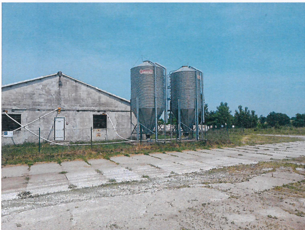
Fot. 3 Działka nr 71/7 obręb Czechy – teren zakładu
