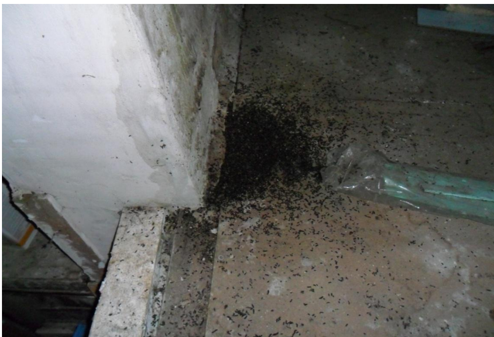
Fot. 4. Ekskrementy nietoperzy na strychu budynku (fot. P. Siuda)
