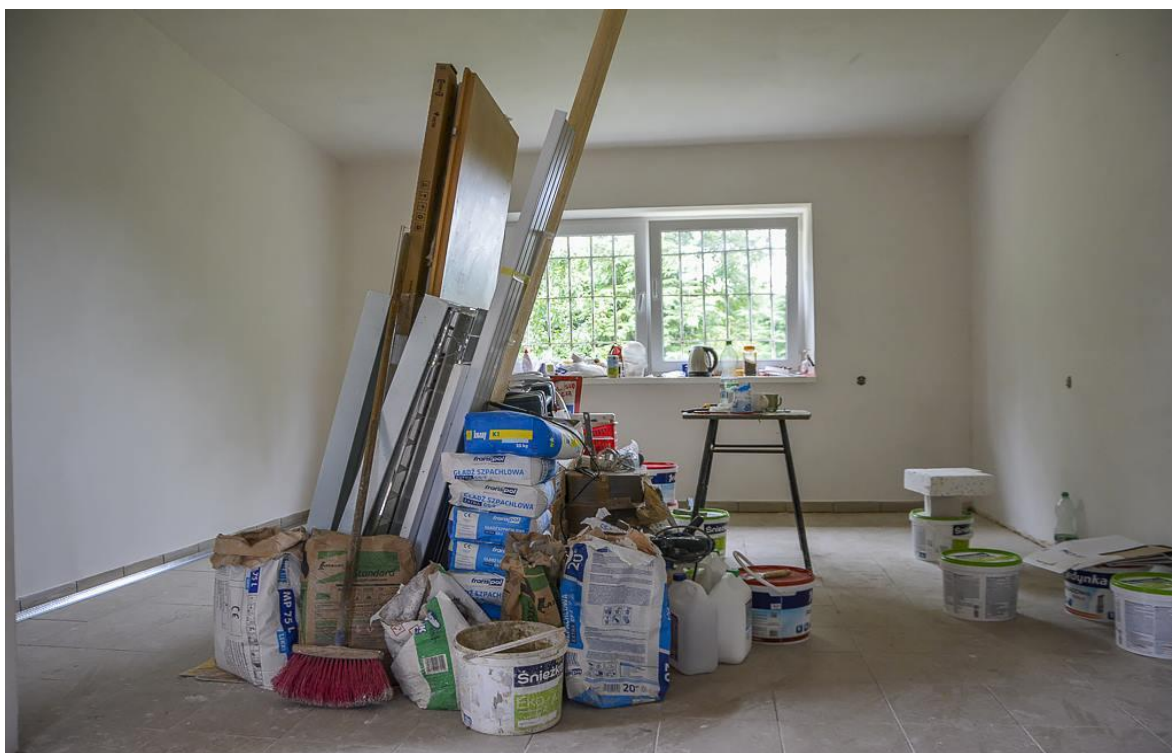
Godziszów realizacja inicjatywy lokalnej 1
