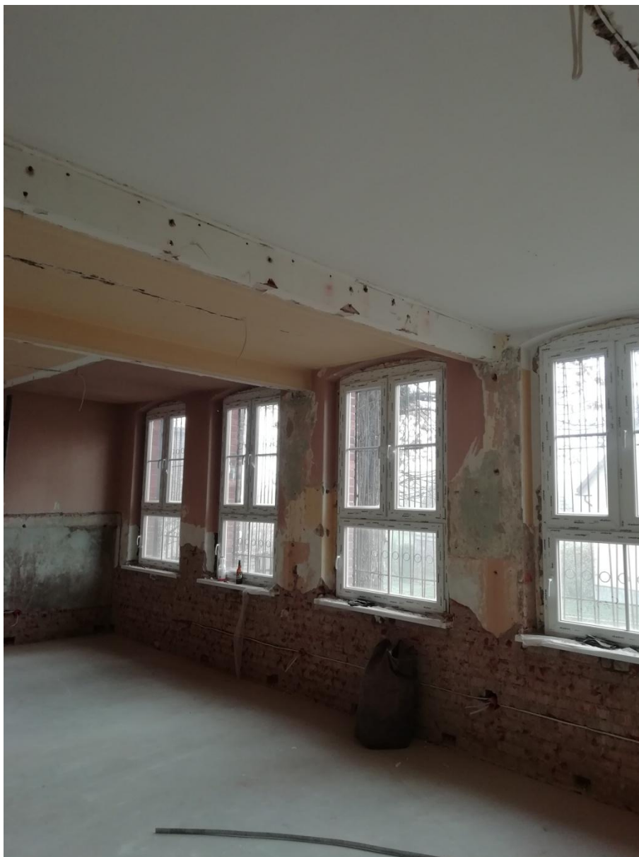
Obrazek 13. Widok pomieszczenia świetlicy wiejskiej w Storkowie w trakcie prac remontowych
