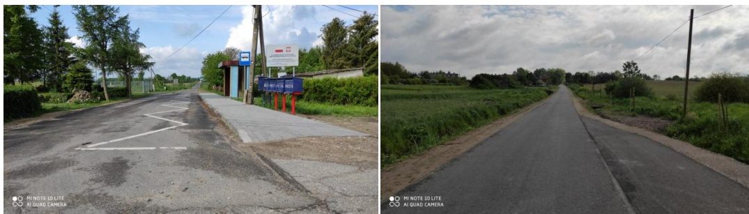
Obrazek 20. Droga do miejscowości Gdaniec
