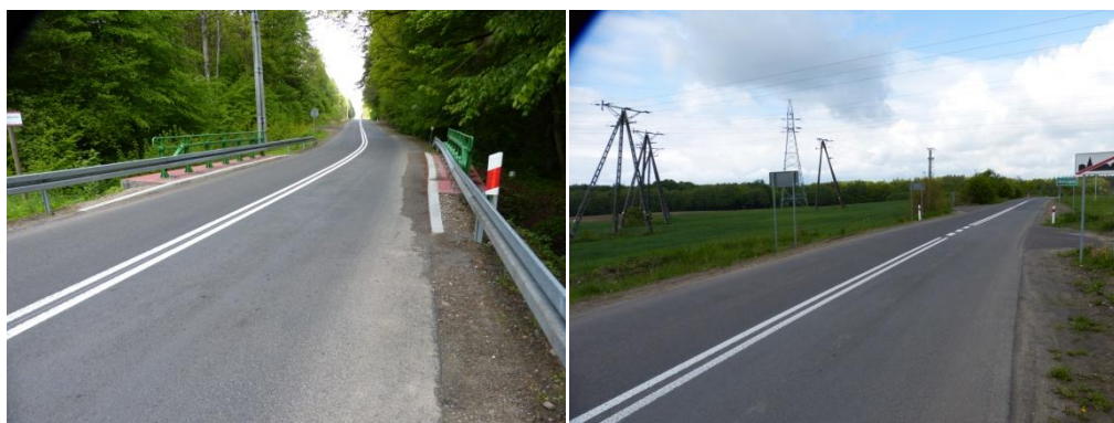
Obrazek 22. Wyremontowany fragment drogi powiatowej nr 1258Z
